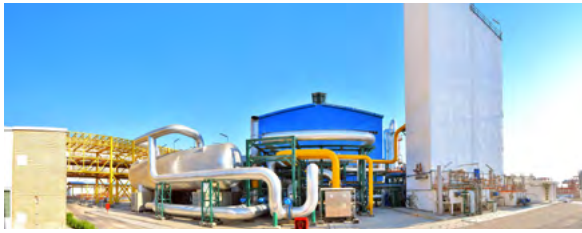
■ واحد RO پلی پروپیلن سپهر مکران استان بوشهر، بندر عسلویه تامین لوله، اتصالات و شیرآلات U-PVC فشار قوی و شیرآلات پروانه‌ای مناسب سیالات اسیدی و آب
